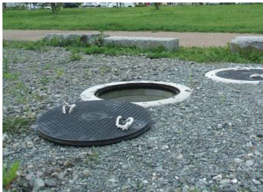
写真7 従来工法1現場
