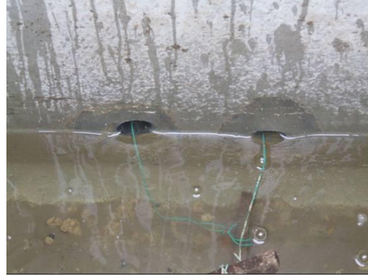
写真 10 従来工法 1 内部 3
