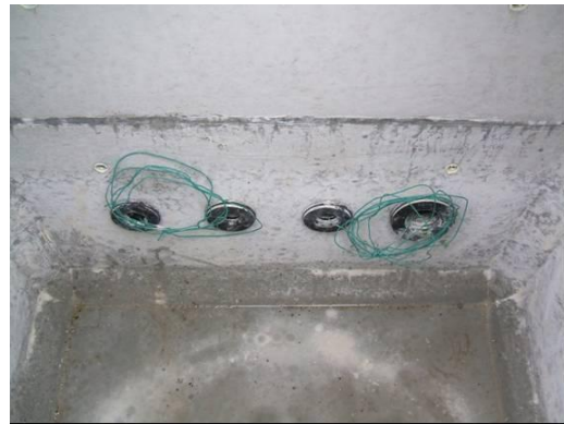
写真4 FF ジョイント1内部4
