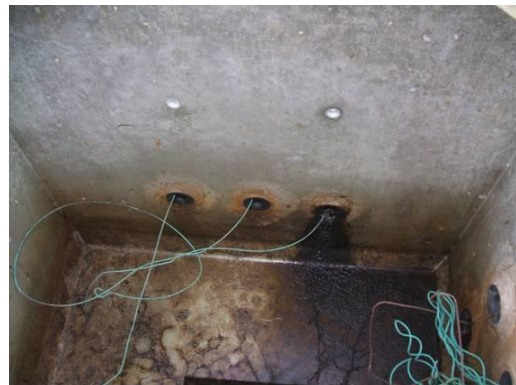
写真 12 従来工法 2 内部
