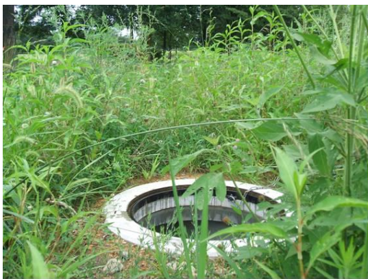
写真5 FF ジョイント2現場
