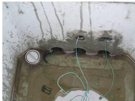
写真8 従来工法1内部1
