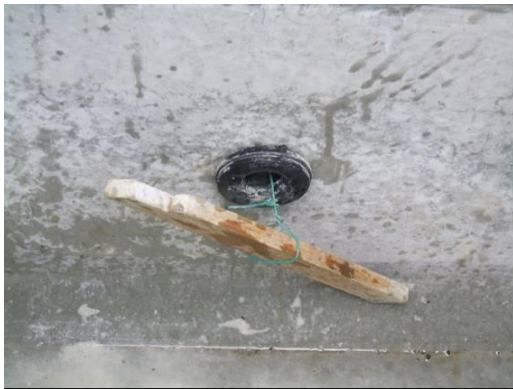
写真3 FF ジョイント1内部3
