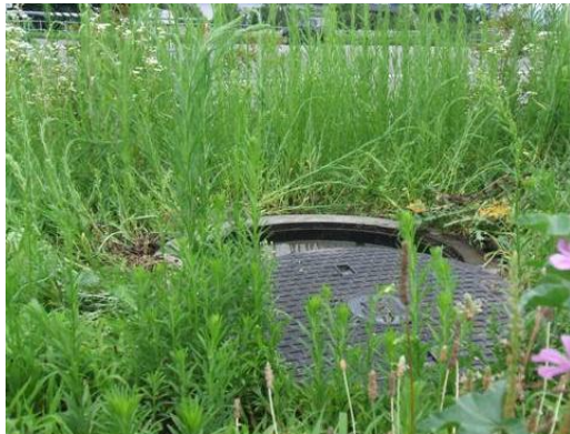
写真 11 従来工法 2 現場
