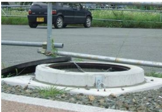
写真1 FF ジョイント1現場
