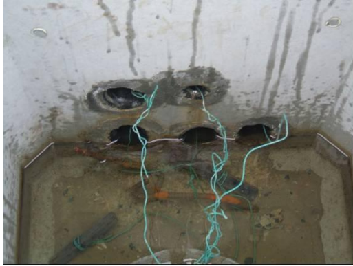
写真 9 従来工法 1 内部 2
