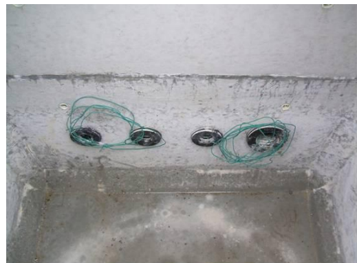
写真2 FF ジョイント1内部1
