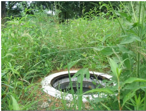
写真5 FF ジョイント2現場
