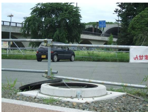
写真 1 FF ジョイント 1 現場
