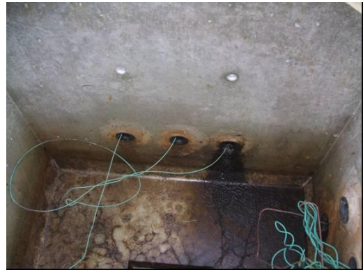
写真 12 従来工法 2 内部
