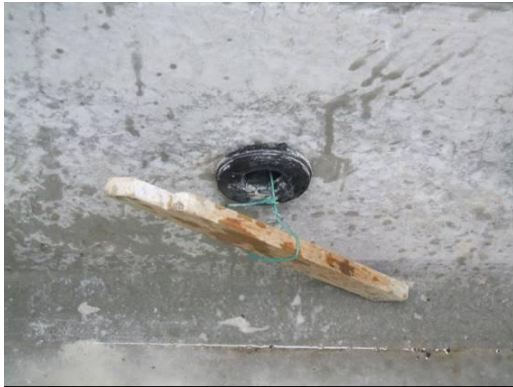
写真3 FF ジョイント1内部3
