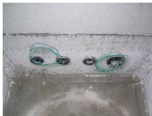
写真 2 FF ジョイント 1 内部 1
