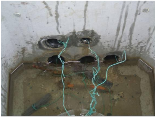
写真 9 従来工法 1 内部 2
