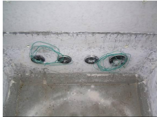
写真4 FF ジョイント1内部4
