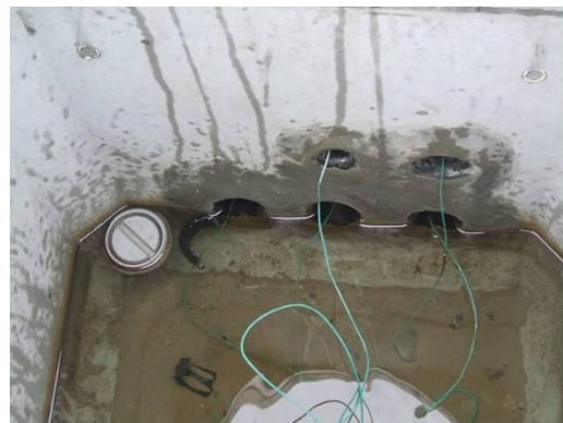
写真8 従来工法1内部1
