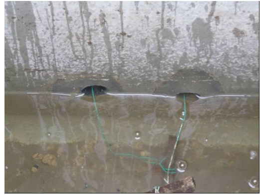
写真 10 従来工法 1 内部 3
