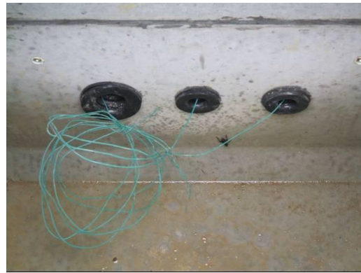
写真6 FF ジョイント2内部
