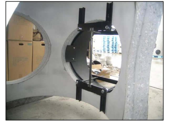
圧入治具取付状況 (マンホール内側)
