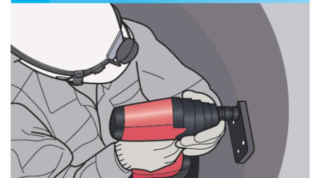
スクリューアンカーでプレートを固定します。
