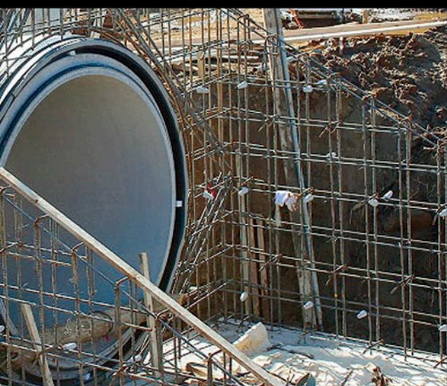
HP-D \phi 2600 (左)、HP-D \phi 1200 (中央)、HP-D \phi 2400 (右) フラット 取付状況
