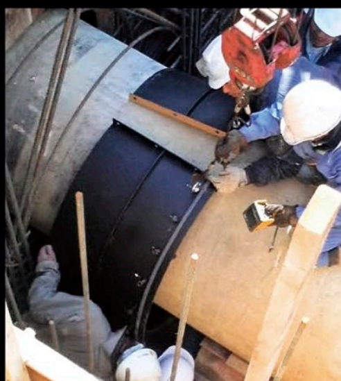
HP φ900 割込人孔（分割）対応品 組立状況
