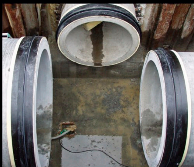
HP-D \phi 2600 (左)、HP-D \phi 1200 (中央)、HP-D \phi 2400 (右) フラット 取付状況
