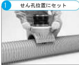
クイックブランチをせん孔位置に合わせてセットします。
