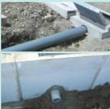
従来の施工例 (モルタル固定)
