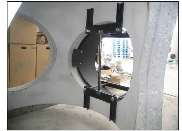
圧入治具取付状況 (マンホール内側)
